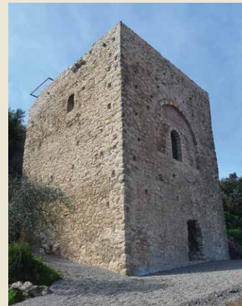
Ο πύργος του Ματζουρανόγιαννη The tower-house of Matzouranogiannis
